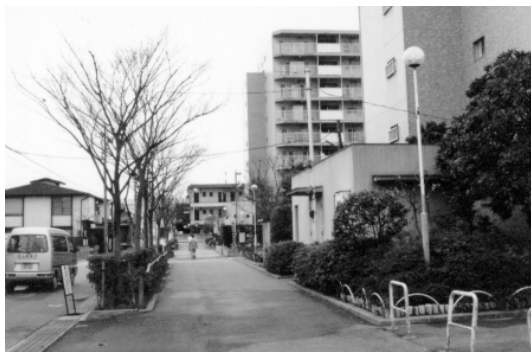
[大規模改修工事前]
