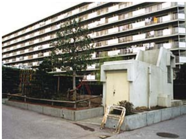
大規模修繕工事(1996年)前のライオン公園周辺
