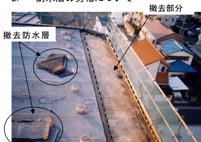
図2 屋上防水層の劣化部撤去状況
