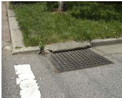
図9 2号棟南西部の縁石の破損部分
