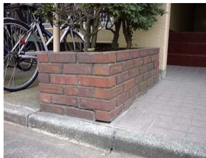
図 21 1号棟第5階段前の植込みのレンガ部の浮き上がり
