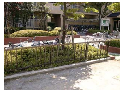
図 25 破損が目立ってきたライオン公園周囲のフェンス
