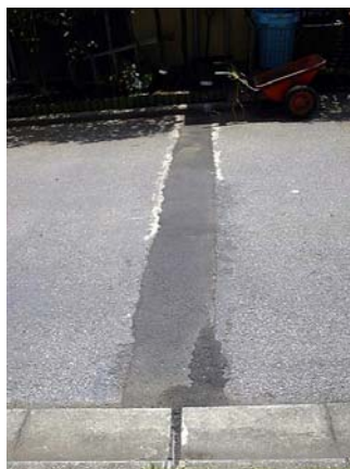
図7 各所の簡易アスファルト舗装 部分
