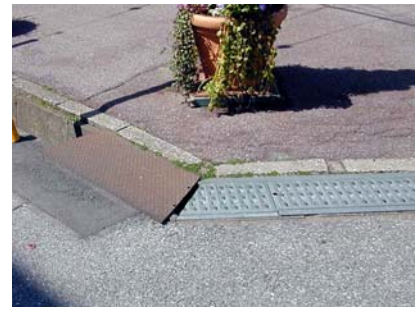
図 19 マンション南東角部の鉄板部分
