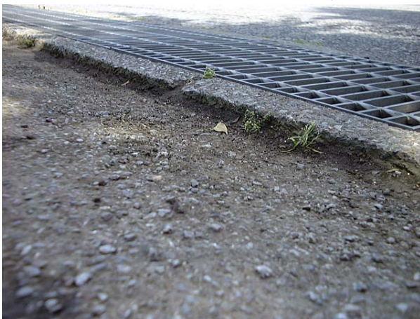
図3 U字溝横のカラーアスファルト舗装の沈下
