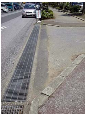
図6 公道手前のU字溝の段差部 (現在、簡易アスファルト)
