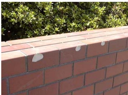
図 20 破損したタイル部分
