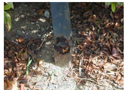
図17 左の掲示板の足元の錆びて穴があいた状態
