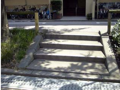
図11 1号棟北側の樹木で傾いた階段
