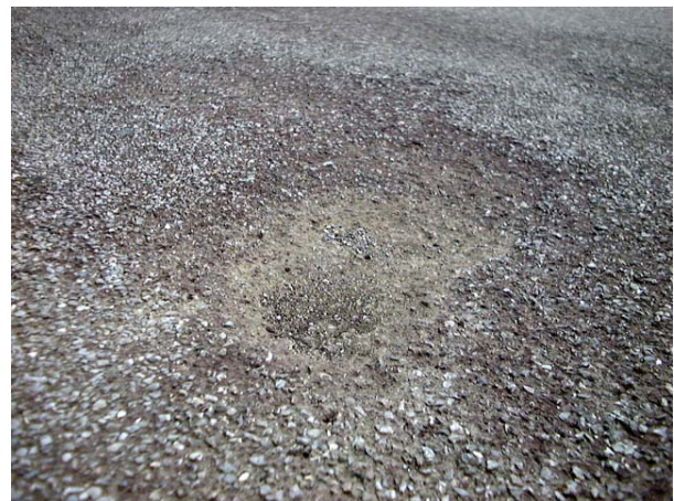
図2 カラーアスファルト舗装のポップアウト
