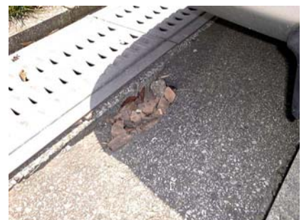
図8 駐車場のアスファルトの穴の あいた部分
