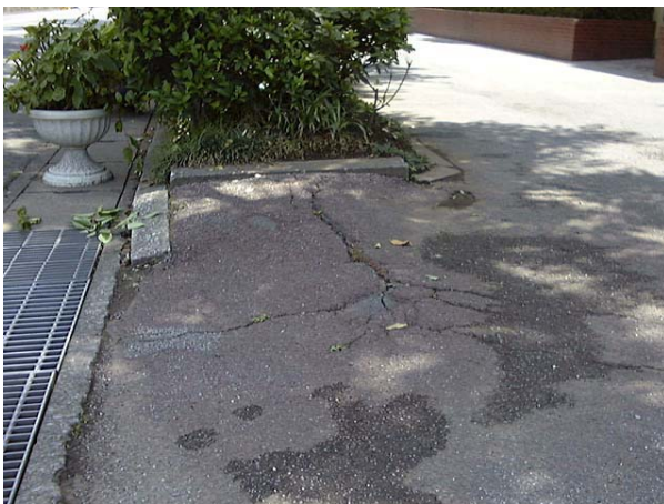
図1 2号棟前のカラーアスファルト舗装の割れ
