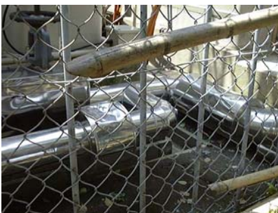
図 24 こどもが乗るために凹んだ配管の保温ラッキング
