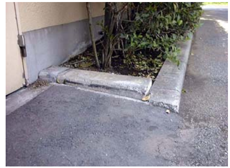
図10 ごみ集積所の縁石が持ち上がって段差となった部分
