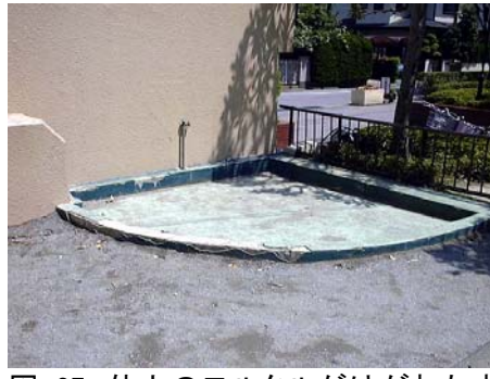
図 27 仕上のモルタルがはがれた水場
