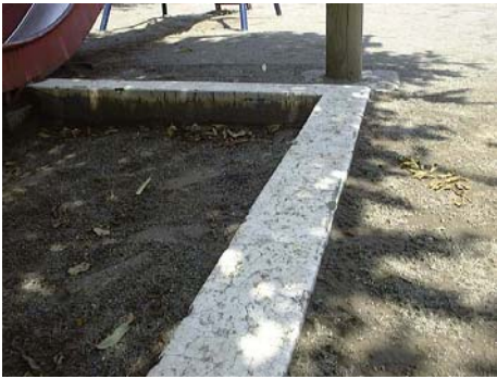
図 26 塗装がはがれ、クラックが目立ってきた砂場の周囲の枠
