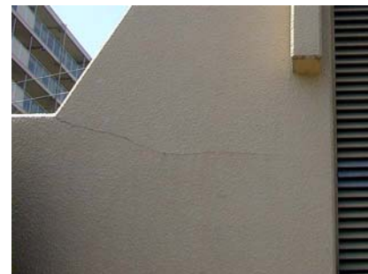
図 22 ライオン公園のコンクリートに生じたクラック
