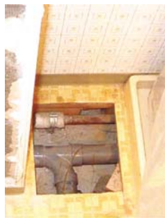
図4 浴室・洗面系統の排水管改修工事
