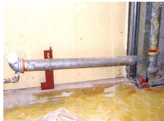
【流し台背面の排水管】
