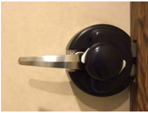
図 3 サムターン回し対策カバーの例
