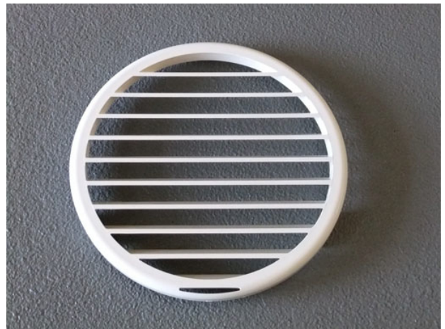
③ 外したガラリ部
