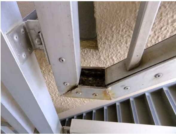
面格子の下部の膨れ状態の例
