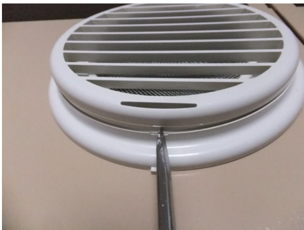
② マイナスドライバーをネジを回す要領でまわすとガラリ部が浮いて外すことができる。
