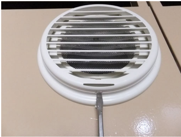
① ガラリ下部の溝にマイナスドライバーの先端を入れる
