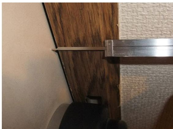
ノギスで三方枠とドアの隙間を測定
