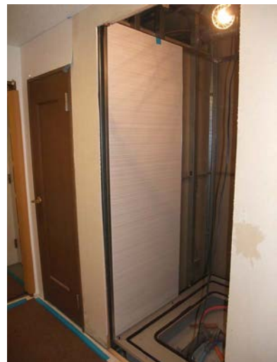
新しいユニットバスの壁面 パネルの取付開始
