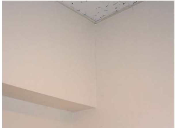
壁クロス張替え後
