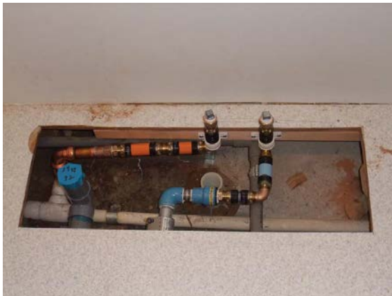
床下の配管を改修した状態
