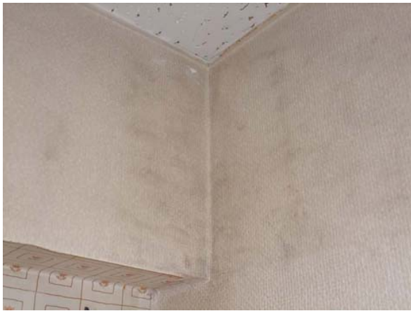
壁クロス張替え前（棚があった部分に昔のチューリップ柄のクロス）
