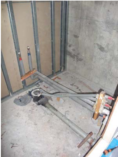
既存の UB 撤去で露出した 設備配管
