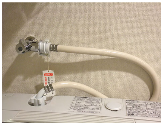
更新した洗濯機用水栓 TW11 (TOTO)
