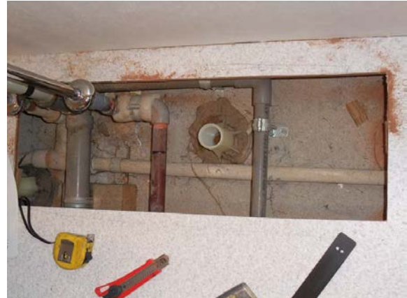
洗面化粧台 LC の配管位置に合わせて床面を大きく開口
