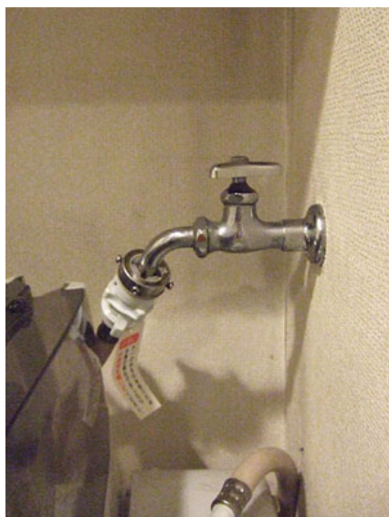
既存の洗濯機用水栓
