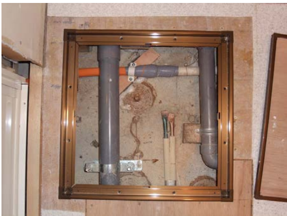
洗面所に設けた点検口下の配管
