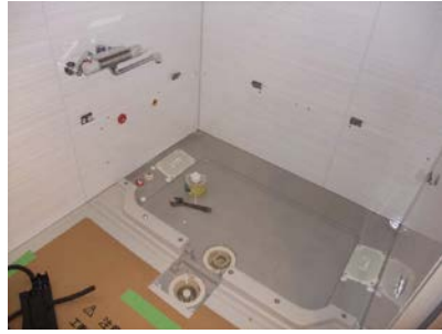
浴槽下の排水用パンを取り付けた状態
