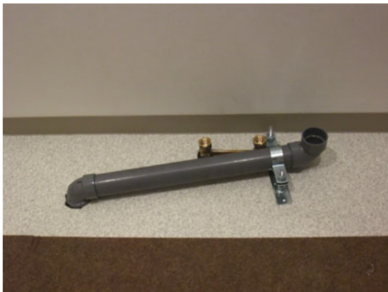
洗面化粧台の台輪（高さ 10cm）の中で排水 水管を横引きして位置を変更
