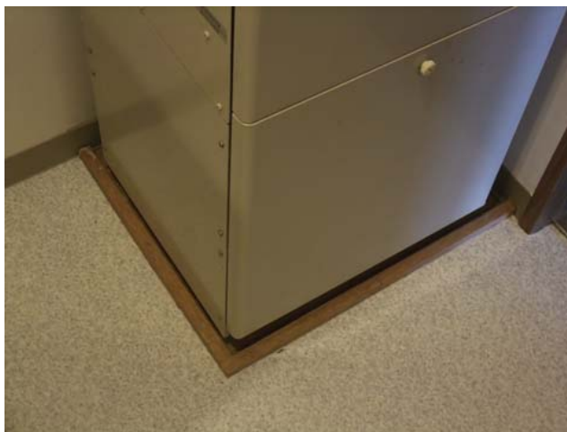
図 20 TES 下のクッションフロアの見切り用の板
