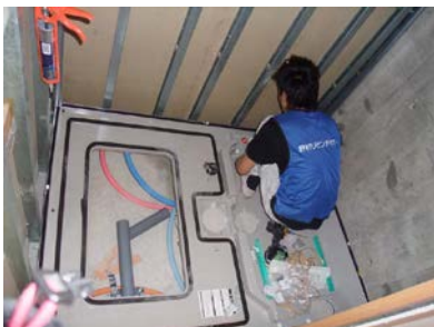
新しいユニットバスの床 部材の組立て状況
