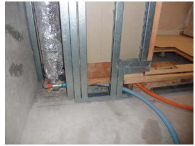
新しい UB のための給水管 （青）、給湯管（オレンジ） を接続した状態。
