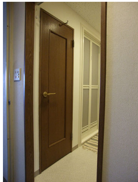
図 23 交換したトイレのドア
