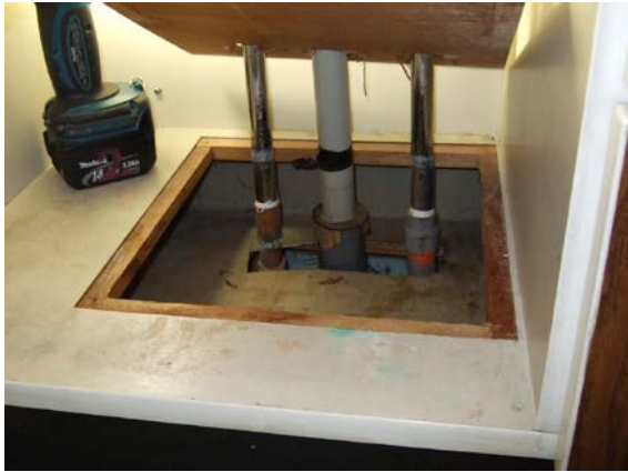
既存の洗面化粧台の配管（左より、給湯管、排水管、給水管）
