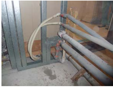
既存の UB の浴槽の縁の中 納められたバスヒーター用 の往還の銅管、給湯用の銅 管、給水管、排水管（上か ら順に）
