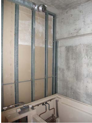
壁が撤去された浴室内
