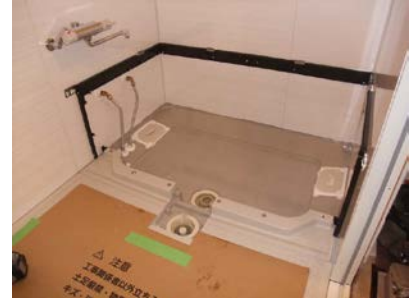
浴槽の下側が汚れないようにオプションで選んだオーバーフローガイドの取付状況
