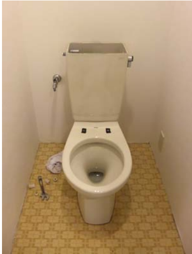
1) 既存のトイレ(撤去前)
