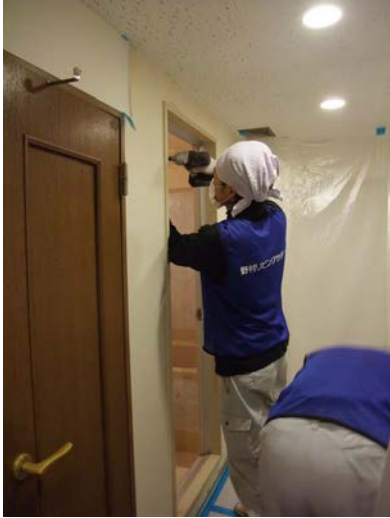
洗面所の養生後、解体開始
