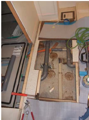
給湯管、排水管の配管のため に洗面所に開けた開口*
