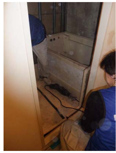
電動ノコで切断、解体
