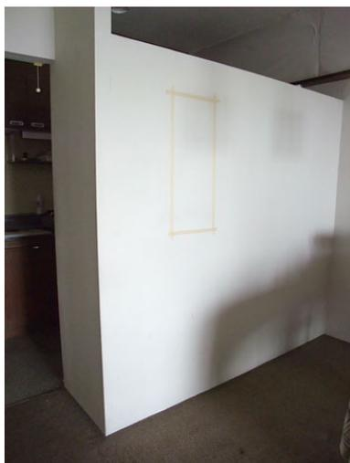
①下地さがしツールで軽量鉄骨の位置を探し、開口部を新設する位置を決定(マスキングテープでイメージを確認)
