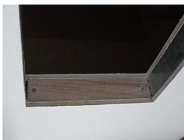
④開口部枠接着用の下地兼横方向補強材取付(平ヤスリで石膏ボードの端面を調整済)
