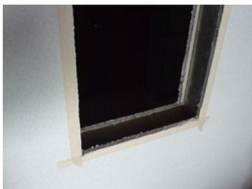
②ボードソーで石膏ボードに開口を設ける。まず小さめに開口を設け、軽量鉄骨の位置を確認して開口範囲拡大。
