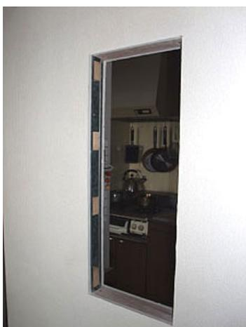
⑤軽量鉄骨に木製ブロックを接着し、開口部枠を接着するための下地とする
