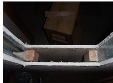
③接着下地兼横方向補強材取付用木製ブロック
