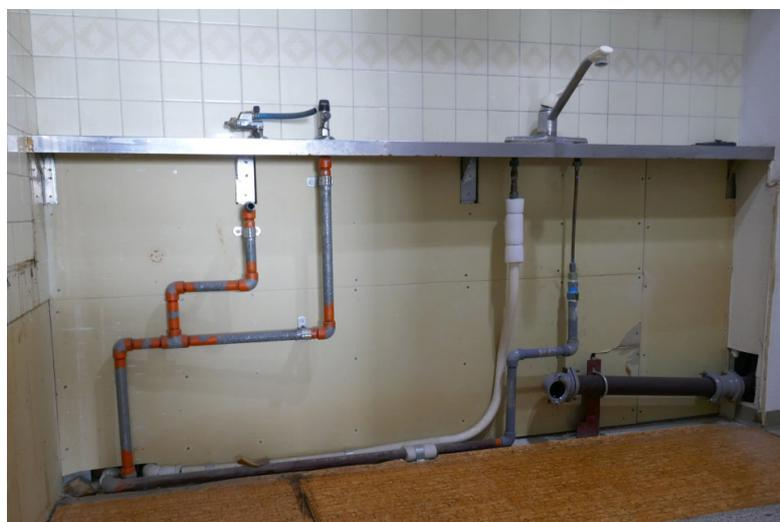
流し台とガス台を撤去後に見えるガス管(左側)と給水管、給湯管、排水管(右側)
