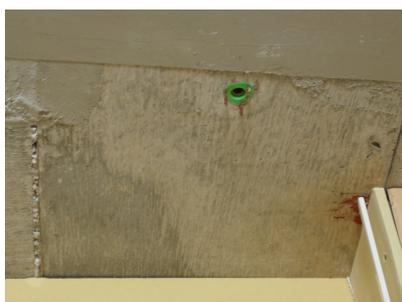
吊りボルトのボルト穴
