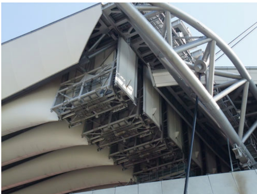
開閉式屋根の端部
