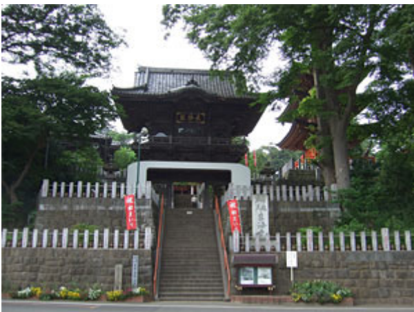
東海寺本堂他（県指定有形文化財（建造物）） 柏市布施 1738
