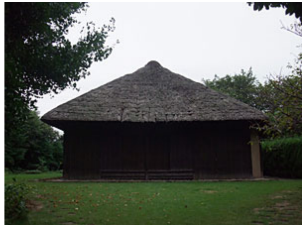
旧花野井家住宅（国指定重要文化財（建造物）） 野田市清水馬作 902（月・火曜休館）
